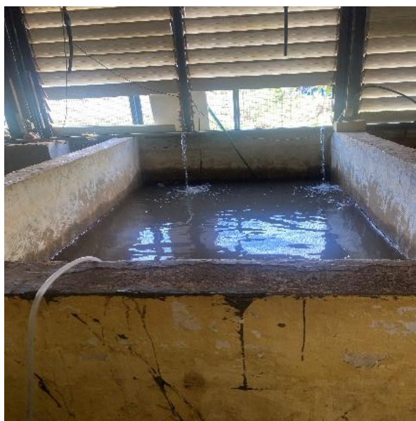
Figure 4 : bac en béton
